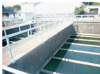
新型脈動式高速凝集沈澱池
