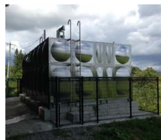
ステンレスパネルタンク 一体型膜ろ過装置
