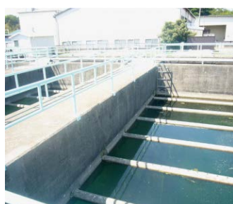
新型脈動式 高速凝集沈澱池
