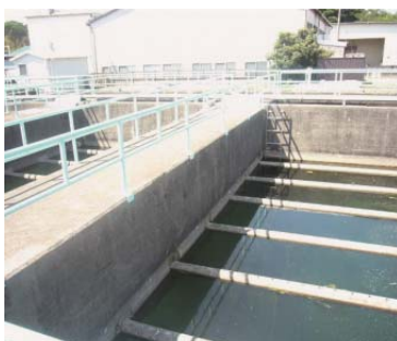
新型脈動式 高速凝集沈澱池
