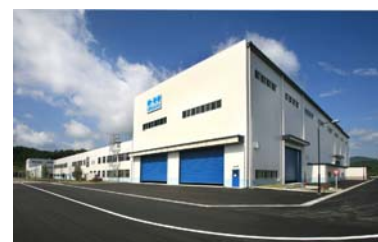
いわき工場 新棟
